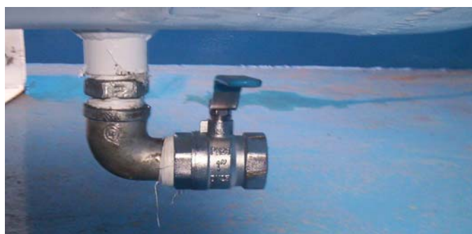
DRENAJE VALVULA SALIDA 1" HILO BSP ( Abajo )
