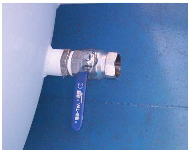
DRENAJE VALVULA SALIDA 1" HILO BSP ( Abajo )
